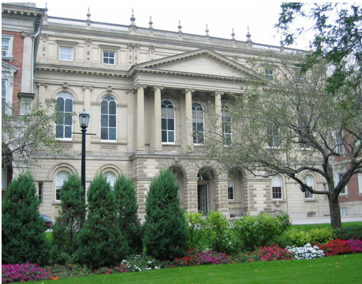
La Cour d'appel de l'Ontario, au Osgoode Hall de Toronto
