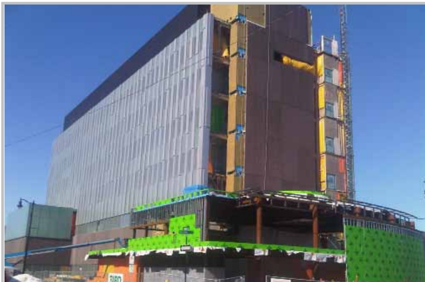
Les travaux de construction du palais de justice polyvalent de Thunder Bay devraient être terminés à l'automne 2013.
