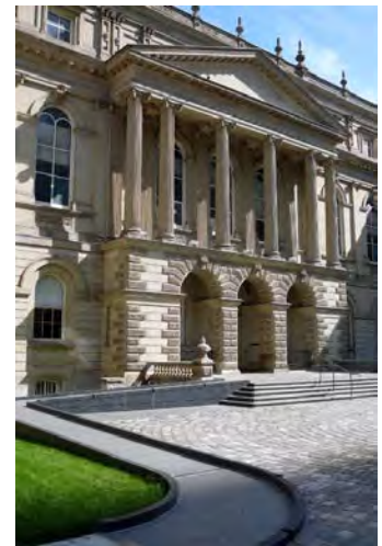
Rampe d'accès pour l'entrée accessible d'Osgoode Hall
