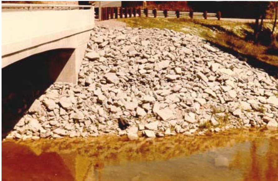
Figure 8.9(d) Random Rip-Rap Slope Protection
