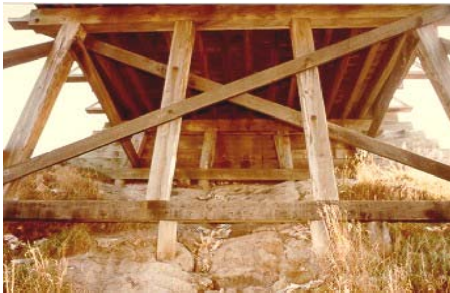
Figure 8.12(d) Wood Trestle
