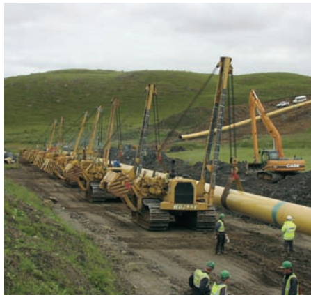
Installation d'un gazoduc de gaz naturel dans le territoire desservi par Scotia Gas Networks
