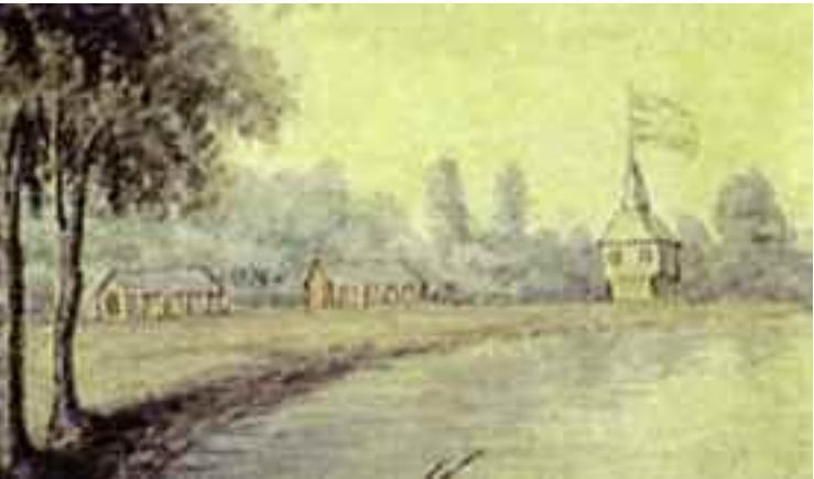
Les bâtiments du premier parlement du Haut-Canada.
