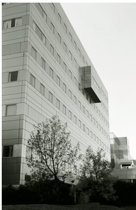
Édifice Willet Green Miller, Sudbury
