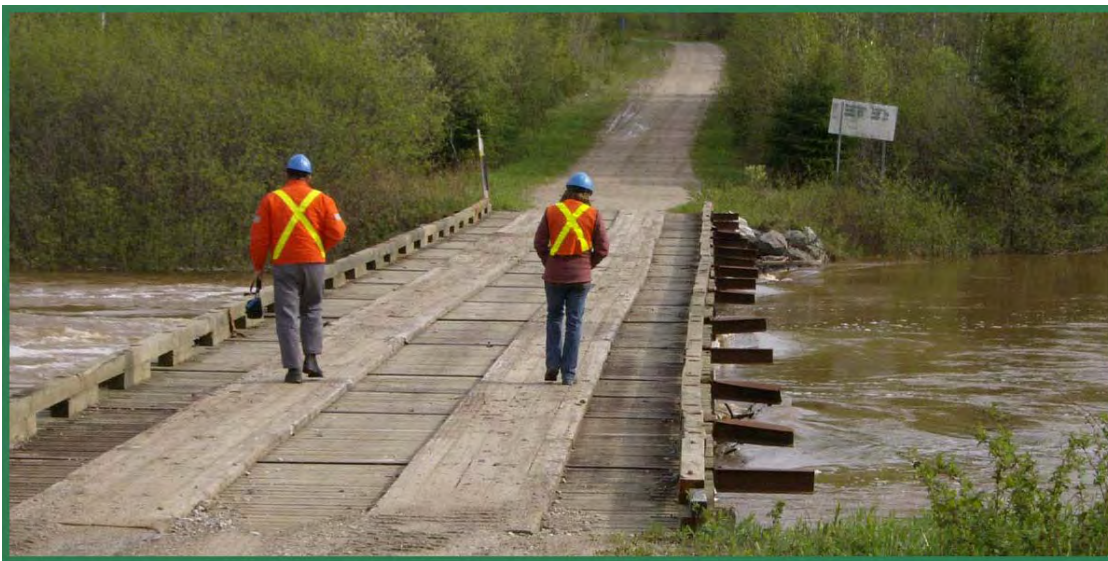
Inspection d'un pont
