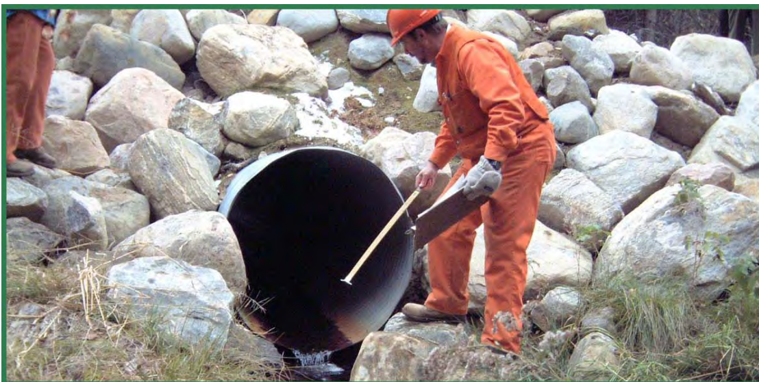
Inspection d'un ponceau (activité de conformité des routes et des traverses d'eau)
