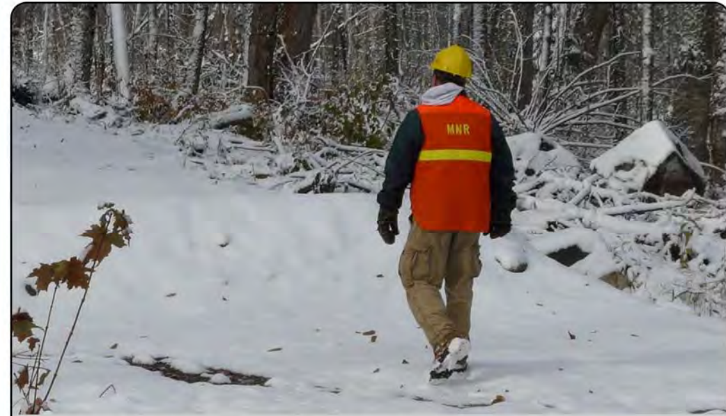
Inspection de l'enlèvement d'un ponceau
