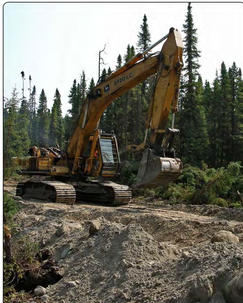
Construction d'une route
