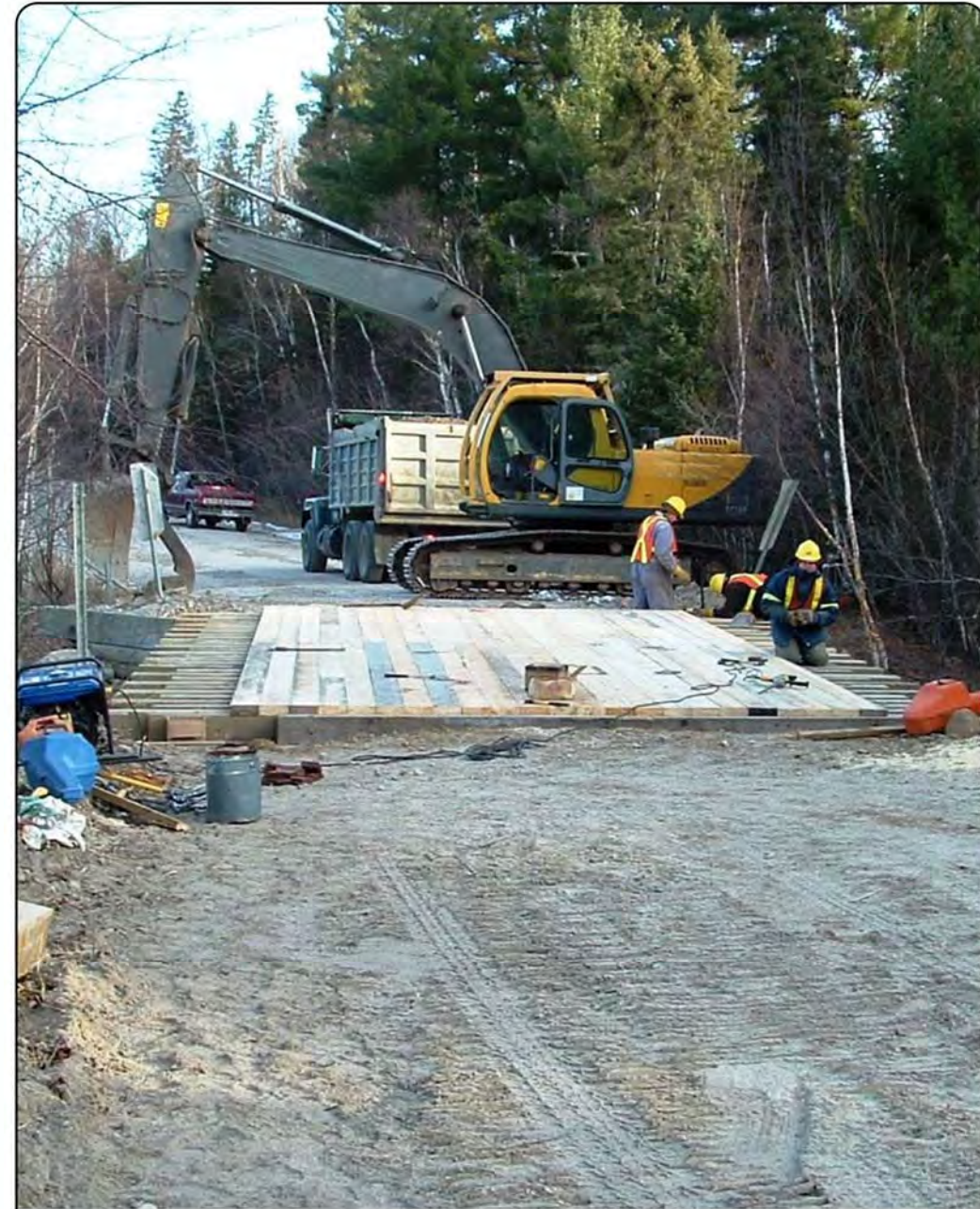
Construction d'un pont
