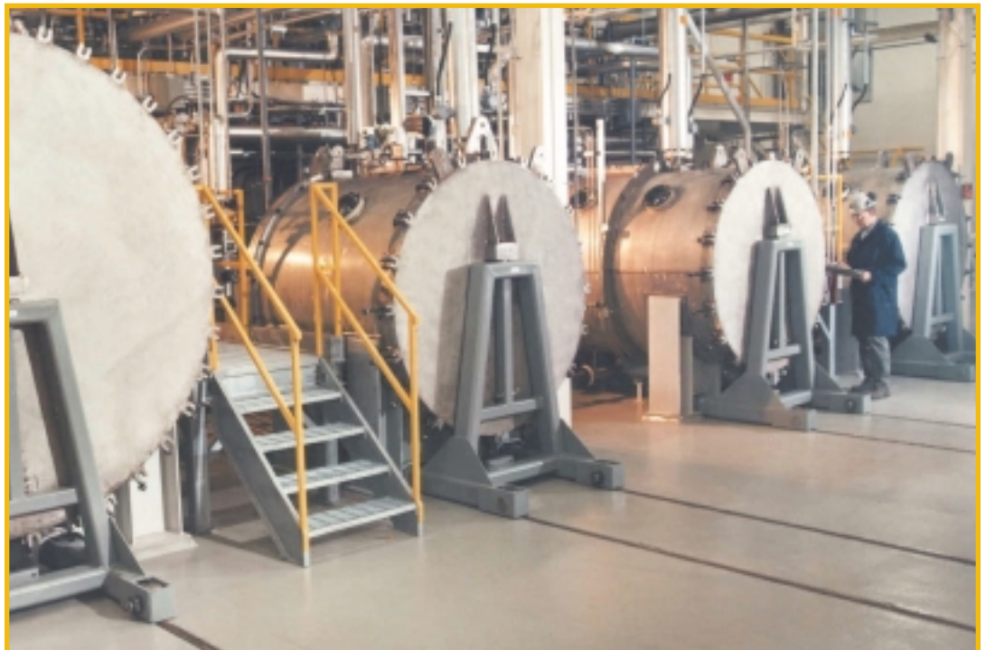
Ci-dessus, les chambres de dépôt servant au procédé de métallisation par dépôt de nickel sous vide utilisées par Weber Manufacturing.
