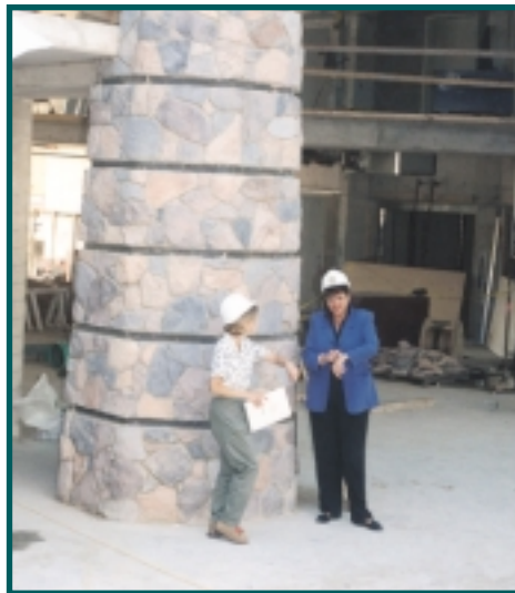
Mohawk Rock a effectué les travaux de maçonnerie en pierre au centre de villégiature Deerhurst, y compris les piliers massifs qui ornent le hall.
