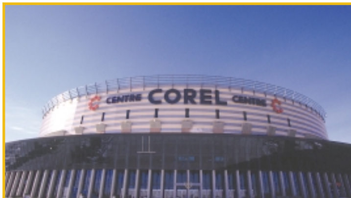
Idéal Revêtement a fourni 136 078 kg de panneaux métalliques pour les murs intérieurs et extérieurs du Centre Corel d'Ottawa.
