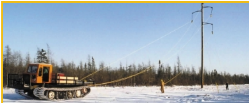
Une équipe de techniciens s'affaire à l'installation de lignes qui achemineront le courant électrique jusqu'aux communautés éloignées du Nord de l'Ontario.
