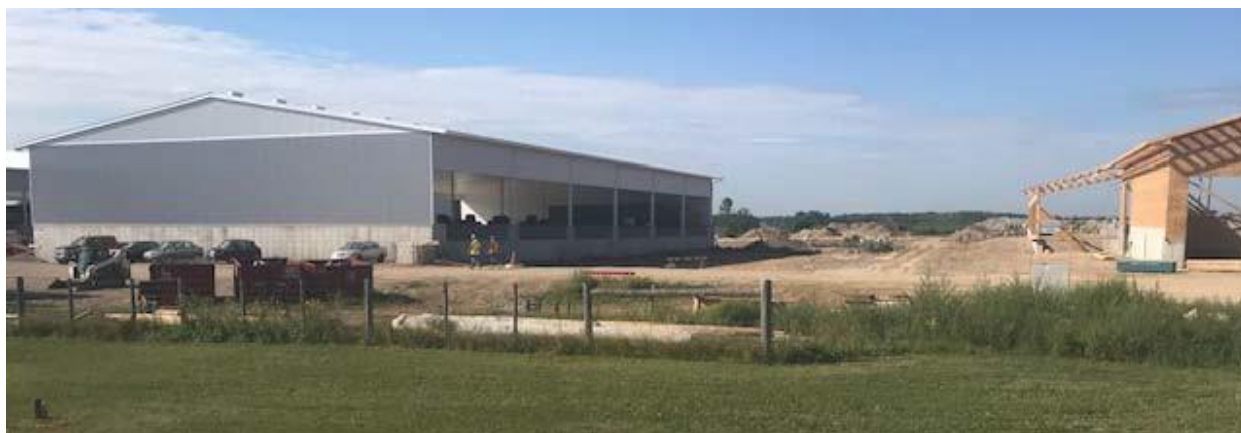
Figure 2 : Entrepôt d'aliments de la station d'Elora en construction.
