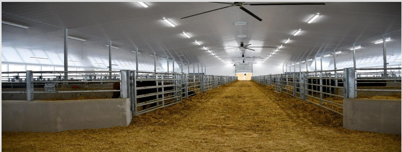
Couloir principal intérieur de la nouvelle étable à vaches/veaux.
