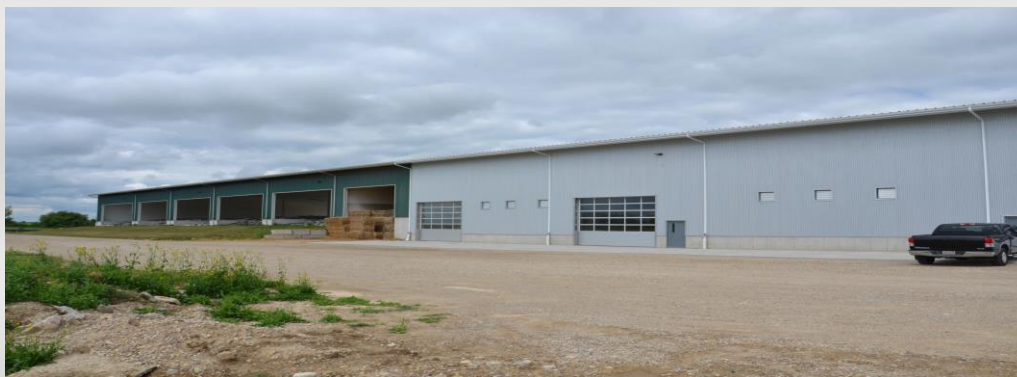
Sortie de la goulotte d'alimentation côté sud du Centre d'alimentation d'Elora.
