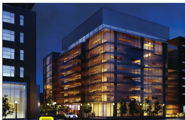
L'édifice de service et de stationnement vu de nuit
