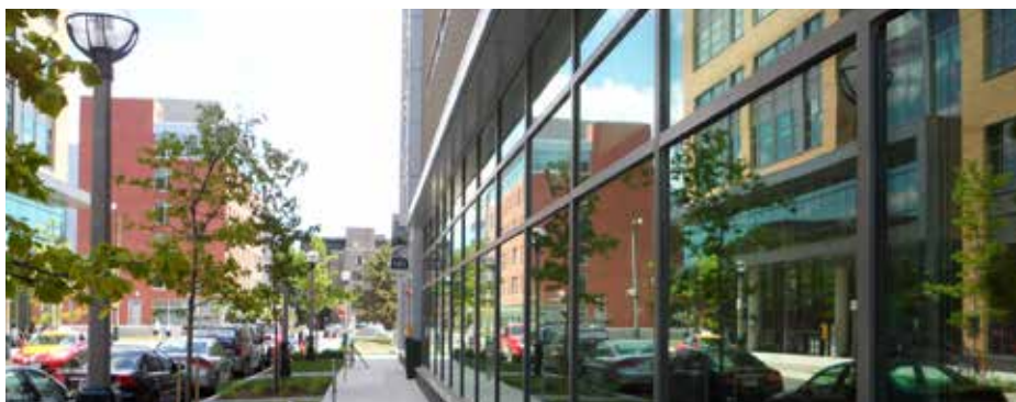
Trois nouveaux édifices : le Centre de bien-être intergénérationnel et l'édifice Bell Gateway se reflètent sur les vitres de l'édifice de l'Association des médecins
