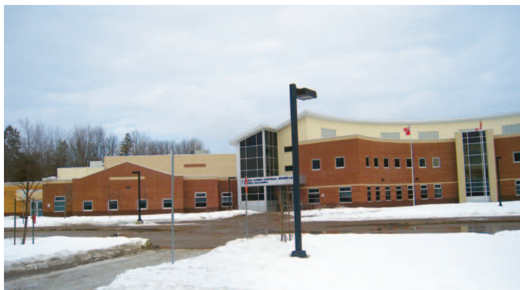
Centre scolaire catholique Jeanne-Lajoie
