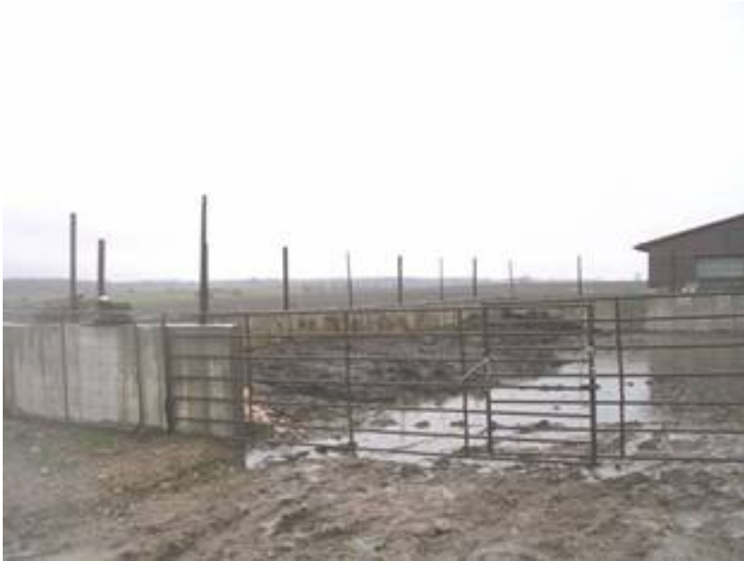
Figure 3 : entreposage de lisier ouvert et enclos de bétail avec un certain confinement des précipitations et des eaux de ruissellement.*
