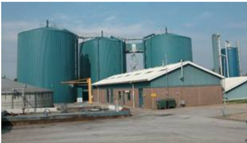
Figure 4 : digesteur vertical à agitation totale
