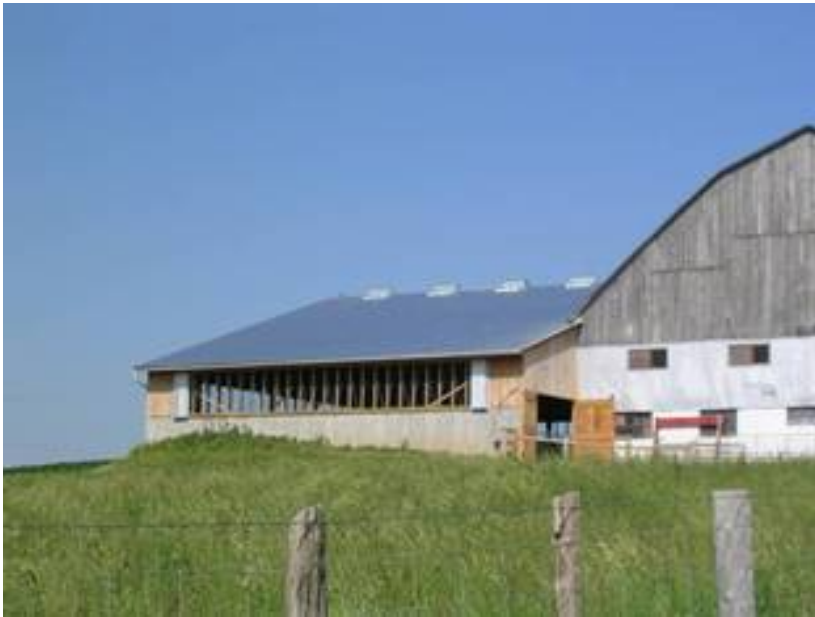
Figure 4 : entreposage de fumier couvert et enclos de bétail (séparé par des murs de béton avec barrières pivotantes) pour éliminer les eaux de ruissellement contaminées.*
