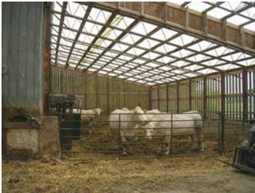
Figure 2 : cour à bétail avec un toit, un socle de béton coulé et des murs de confinement pour éliminer le ruissellement du lisier et protéger des précipitations (pluie, neige).*
