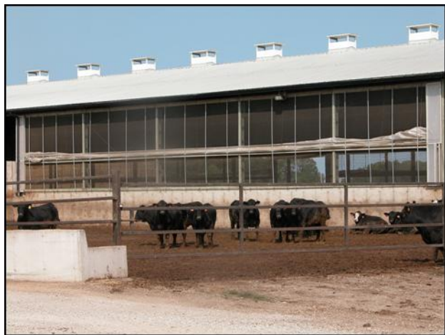
Figure 1. La ventilation naturelle exige de grandes ouvertures dans les murs.
