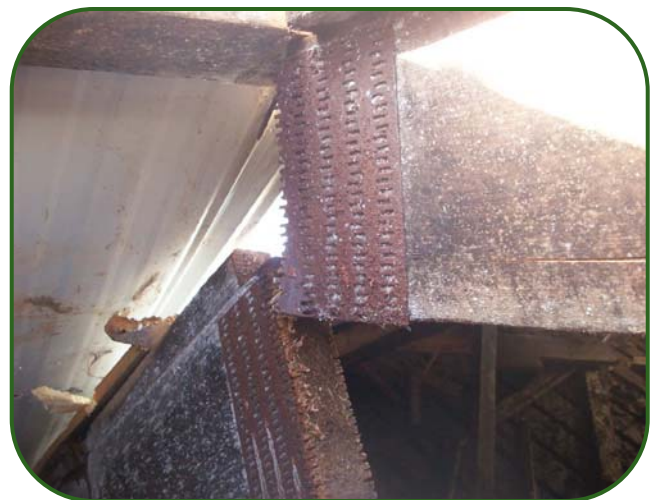
Figure 1. Détérioration des goussets métalliques avec l'humidité et le temps
