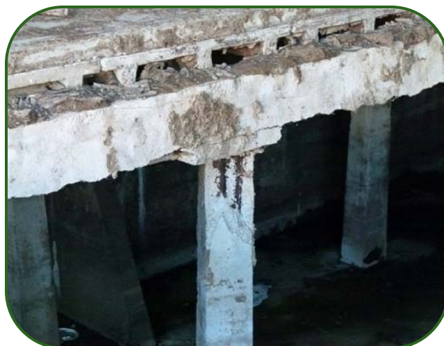
Figure 2. Détérioration des plaques, des poutres et des poteaux exposés aux gaz des fumiers
