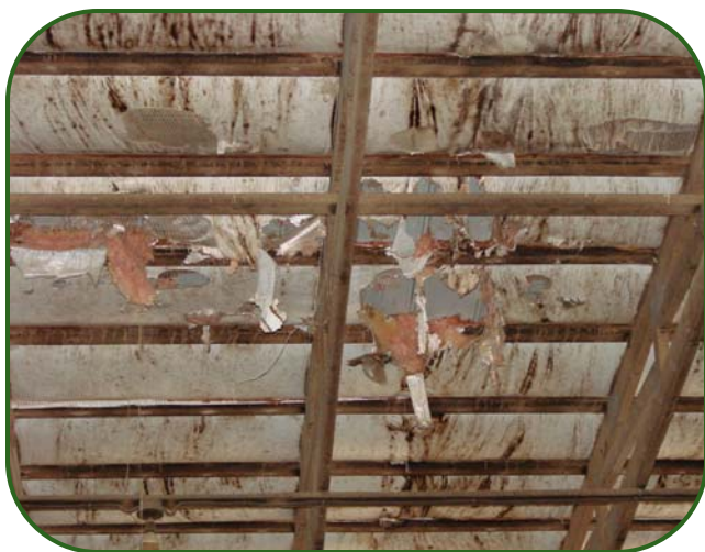
Figure 3. Les oiseaux et les rongeurs endommagent les isolants non protégés
