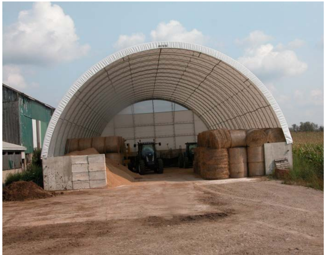
Figure 1 : Photo d'un bâtiment à recouvrement textile de forme arrondie et ouvert aux deux extrémités servant à abriter un tracteur et des balles rondes.
