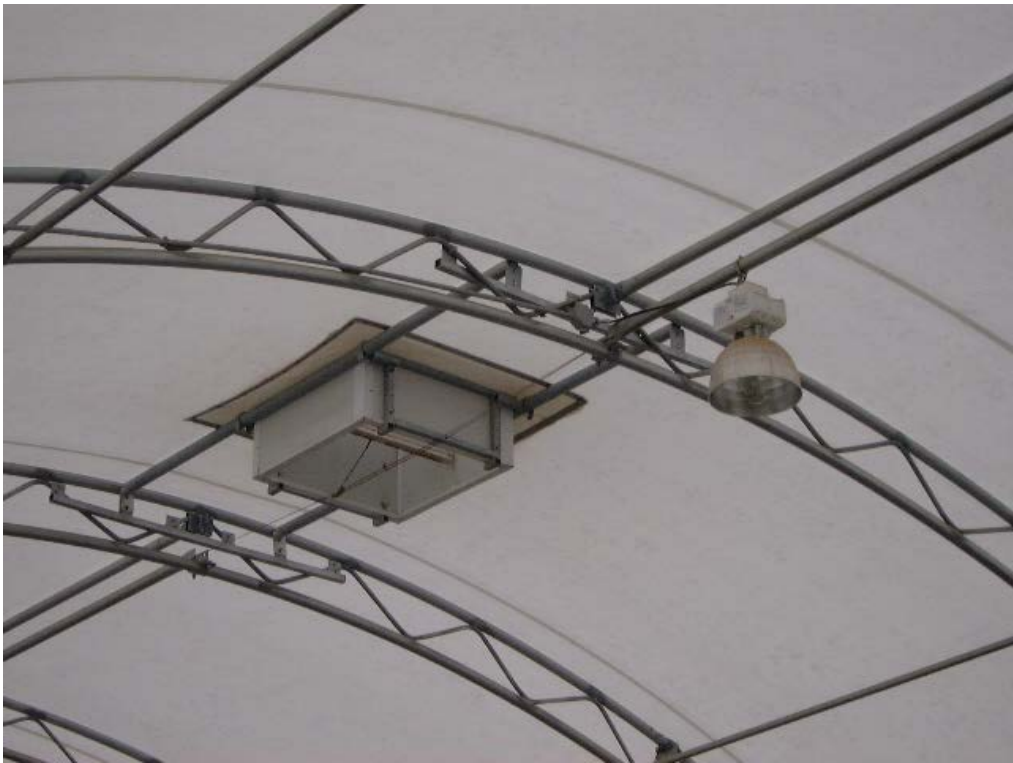
Figure 2 : Photo rapprochée de la toiture d'un bâtiment à recouvrement textile où l'on peut voir une cheminée d'aération, l'armature de soutien et une lumière.
