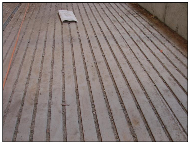
Figure 3. Rainures en forme de losange pour améliorer l'adhérence
