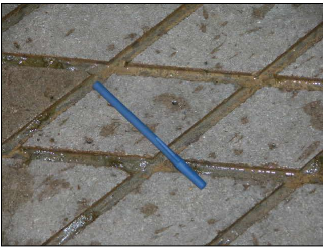
Figure 2. Rainures longitudinales pour améliorer l'adhérence
