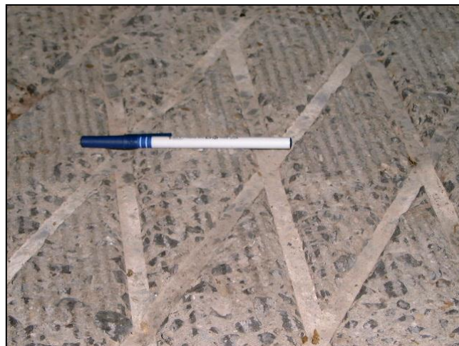
Figure 4. Fraise en surface pour améliorer l'adhérence
