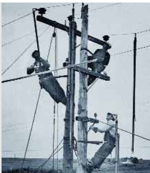
À gauche : Monteurs de lignes d'Ontario Hydro munis d'outils isolants en train d'exécuter des travaux sur des lignes sous tension, le 11 juin 1947.
