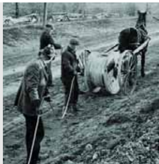
À gauche : Pose de câbles à l'aide de la seule force d'un cheval, près de Beamsville, Ontario, le 22 novembre 1923.
