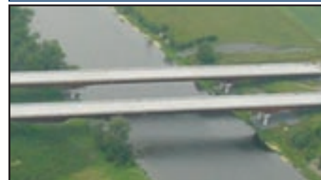
Les ponts jumeaux de la rivière Mississippi qui soutiennent l'autoroute 417 au-dessus des sols marécageux de la rivière Mississippi, dans la vallée de l'Outaouais.
