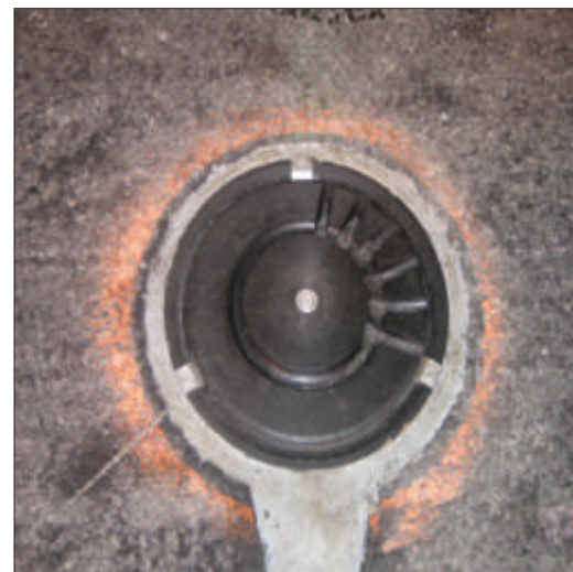
Ci-Dessus: Technologie d'arrosage automatique fixe (FAST) sur les rampes d'accès et les structures.
