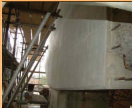
Ci-Dessus: Fini de la surface en béton auto-compactant du quai du Garden City Skyway.
