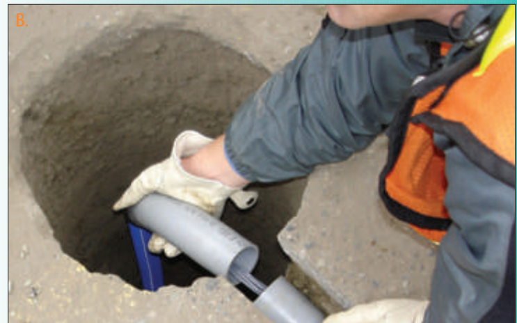
C. Fil de capteur à thermistor non installé avant de le mettre en place (photo du laboratoire sur les chaussées John J. Carrick du centre de la technologie des chaussées et des transports de l'Université de Waterloo).
