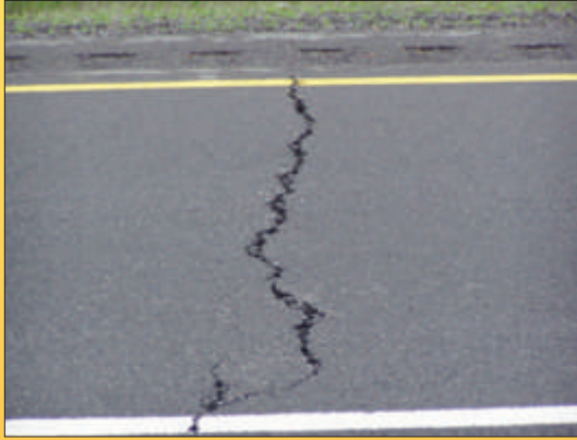
Une fissuration prématurée réduit le rendement global du revêtement.
