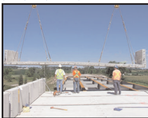
Autoroute 401/Passage inférieur de Mull Road: Dalles préfabriquées d'épaisseur et de largeur complètes
