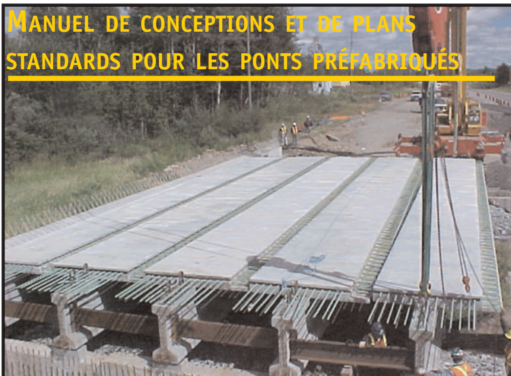
Pont du ruisseau Moose, route 101: Poutres préfabriquées
