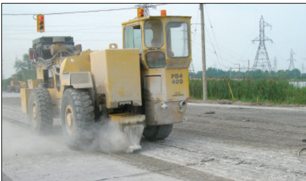
La technique de fragmentation par résonance utilise une fréquence de 44 Hz pour une semelle de 200 mm afin de démolir avec précision le revêtement en béton.
