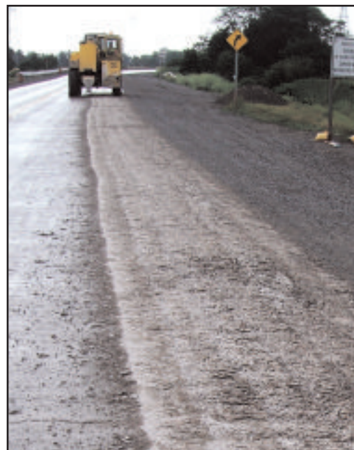
La fragmentation s'effectue en commençant par la ligne médiane ou le bord extérieur du revêtement en y faisant plusieurs passages minces.
