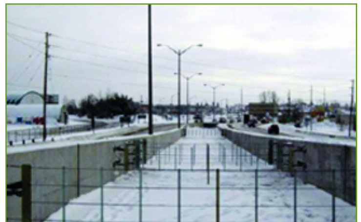
Système de filets d'arrêt du lit d'arrêt d'urgence pour camions.
