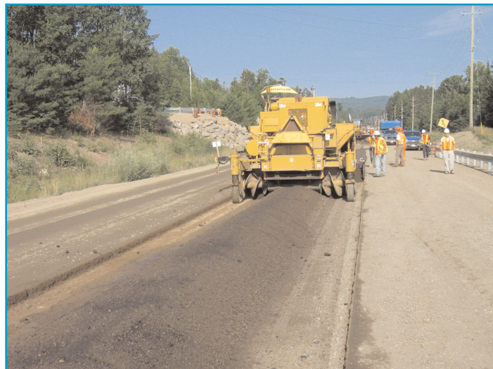
Illustration 1: Recyclage à froid in situ en action.
