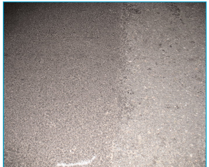
Figure 2 : Gros plan du revêtement avant et après le traitement à l'eau sous pression. La surface avant le traitement est à gauche, alors que la surface après est à droite. Notez la disparition de la pellicule d'asphalte en excès de la surface.
