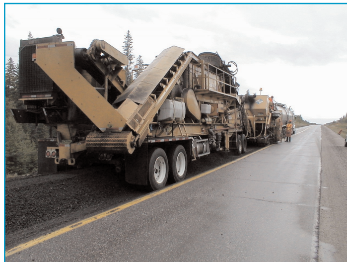
Illustration 2: Train et équipement de chantier de recyclage à froid in situ.
