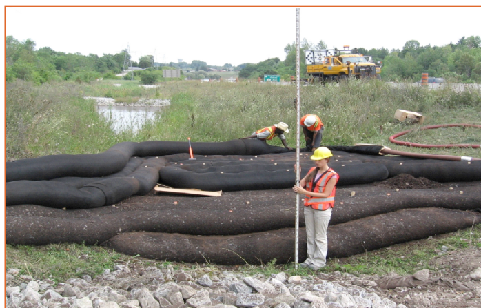
Figure 1 – Biofiltre à base de compost installé dans le fossé situé sur le flanc est de l'Autoroute 8 près de la rue Cameo à Kitchener (Ontario). La personne qui tient la mire est Karen Finney, étudiante diplômée de l'Université de Guelph qui a dirigé ce projet de recherche.
