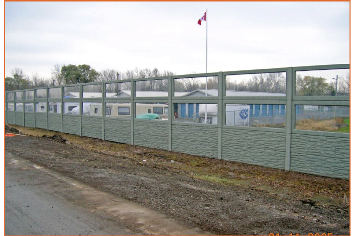
Figure 1 – Maintien de la visibilité des commerces par la diminution de la hauteur du mur opaque le long de l'autoroute QEW près de Fort Erie
