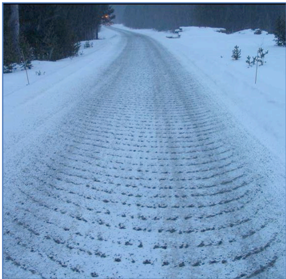
Cette méthode de sablage a tout simplement recours à un mélange d'eau chaude et de sable.
