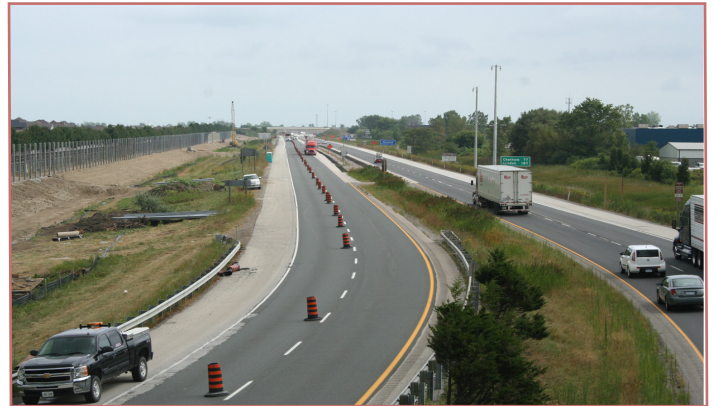
La partie gauche de cette photo montre des poteaux anti-bruit en train d'être « plantés » le long de l'autoroute 401 à la hauteur de Tecumseh, avant l'installation d'un ouvrage anti-bruit.
