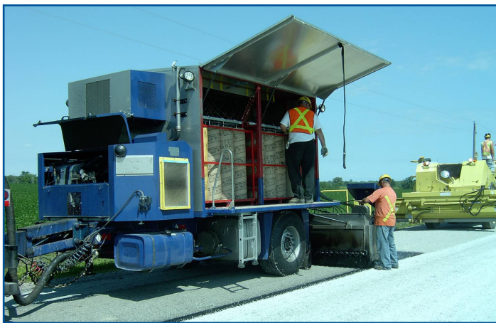
Un chargement de 40 rouleaux de fibre de verre, capable de couvrir 25 000 m 2 .
