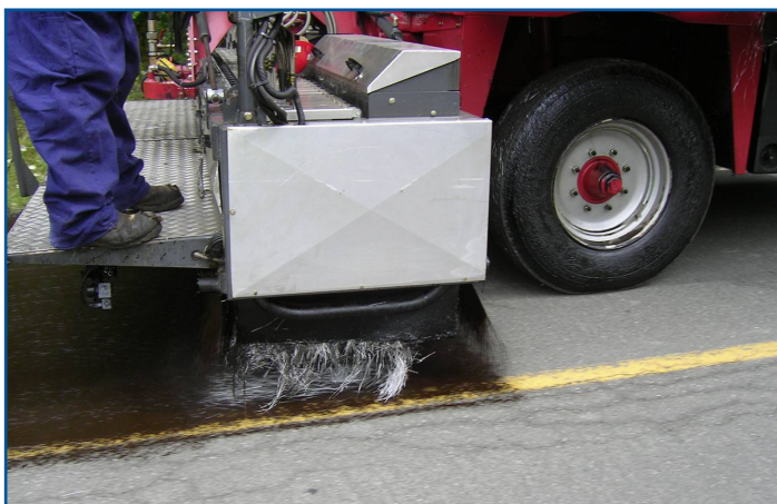
Membrane SAMI appliquée sur la surface de la route contre la remontée des fissures.
