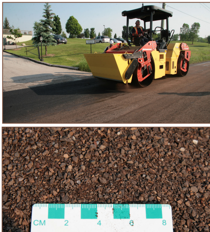
Figure 3 : Gravillonneuse sur les lieux de la démonstration à Burlington et gros plan du gravillonnage enrobé non compacté (fond).
