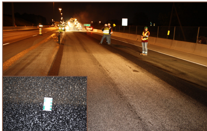
Figure 7 : Texture de la surface SMA terminée traitée au sable de gravillonnage enrobé et gros plan (en bas à gauche) illustrant les différences entre les textures de la surface SMA avec ou sans gravillonnage.
