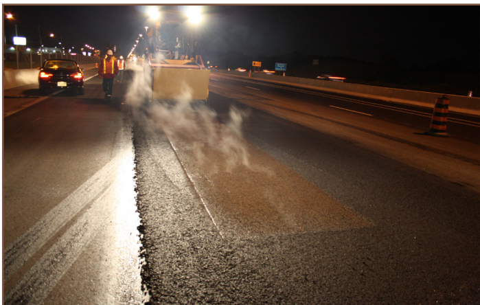
Figure 5 : Gravillon enrobé intégré au rouleau sur la surface SMA chaude.
