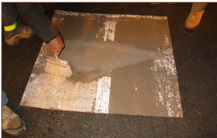
Figure 4 : Vérification du taux d'application effectuée avant l'asphaltage. Pour l'application de sable de gravillonnage non enrobé, la surface finie au SMA a été balayée pour enlever tout excès de sable (flottant).
