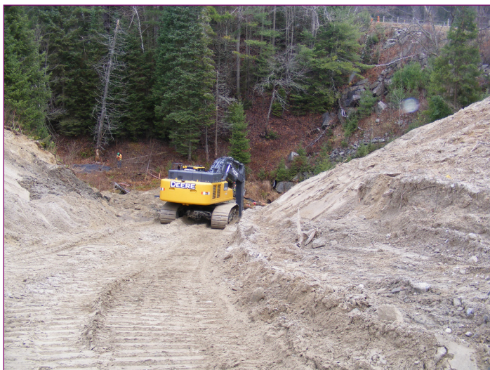
Figure 4 : Voie d'accès pour le puits de sortie située à l'ouest de la voie direction sud
