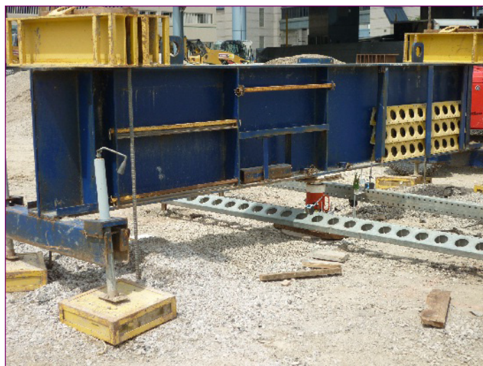
Figure 6 : Mise en place d'un essai de charge de module.
