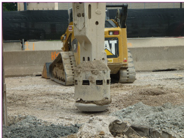
Figure 3 : Une dameuse biseautée augmente la pression latérale.
