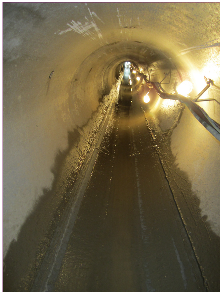
Figure 5 : Installation de tous les tronçons de tuyaux en béton dans le tunnel
