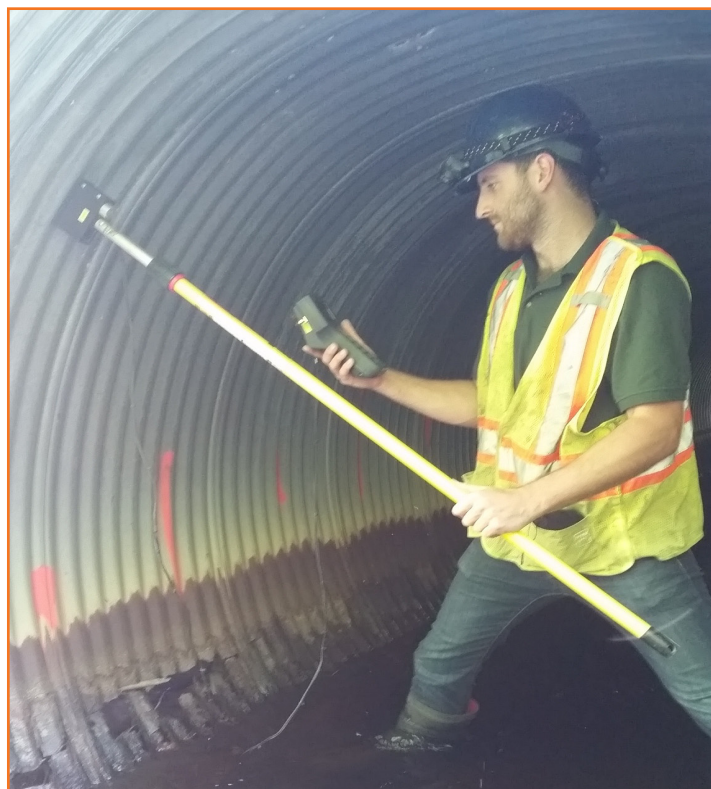
Un technicien d'inspection de ponceau utilise la baguette portative pour repérer les vides dans le sol.
