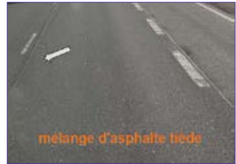
Figure 3 : Photos de sections en enrobés tièdes et en enrobés à chaud sur la route 11 montrant la qualité supérieure du joint longitudinal des enrobés tièdes.
