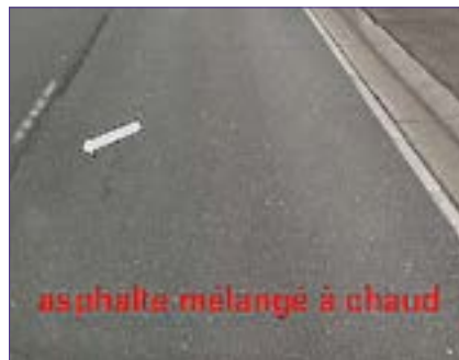
Figure 3 : Photos de sections en enrobés tièdes et en enrobés à chaud sur la route 11 montrant la qualité supérieure du joint longitudinal des enrobés tièdes.
