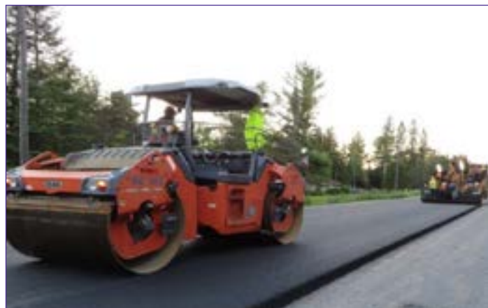
Opération de pavage d'asphalte à mélange chaud montrant un rouleau de chaussée.
