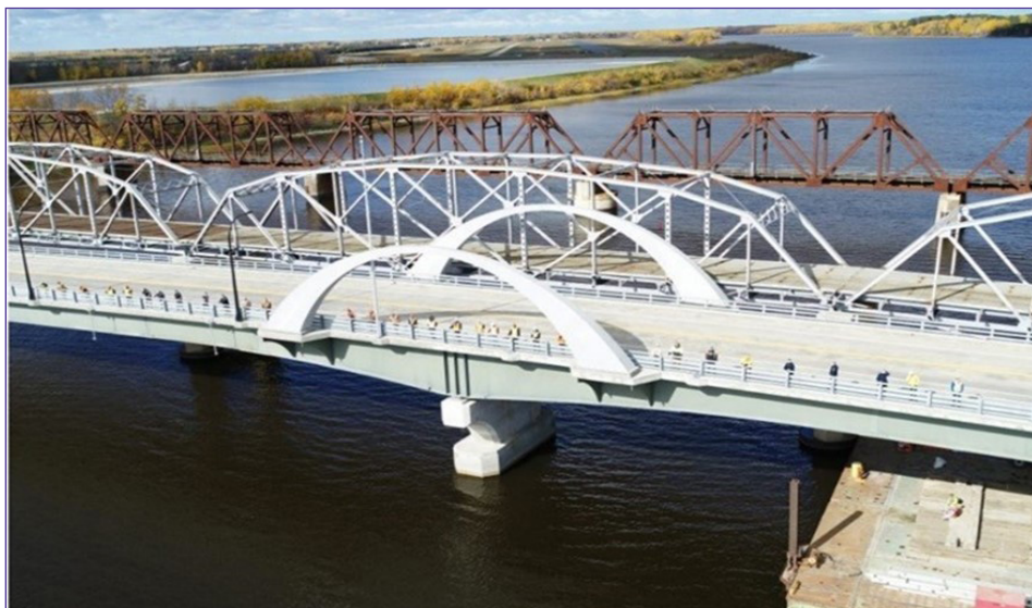
Les principaux collaborateurs du projet se tiennent à deux mètres les uns des autres le long du nouveau pont international.
