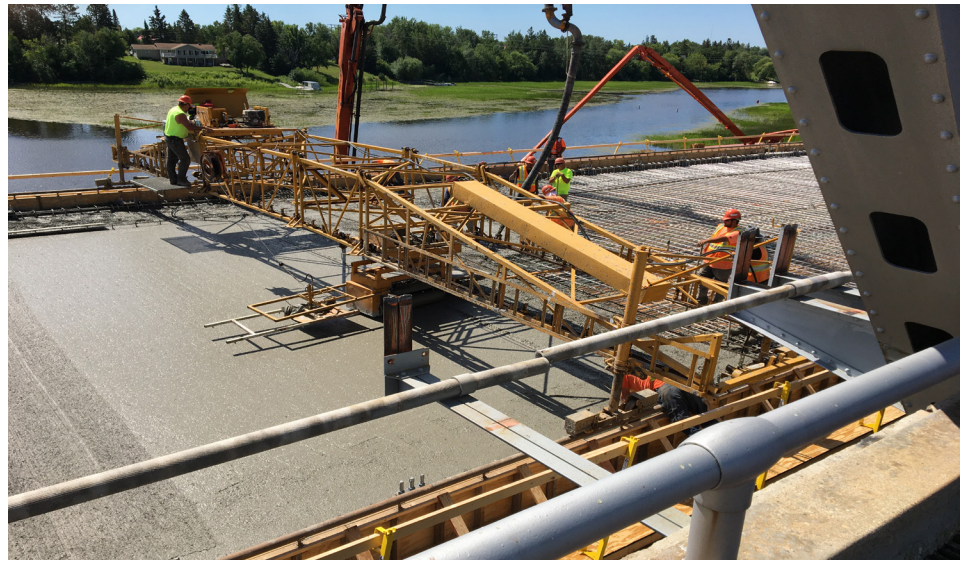
Un entrepreneur nivelle le béton du nouveau tablier coulé sur place à l'aide d'une machine Bid-Well.
