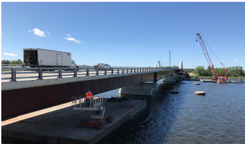
Un entrepreneur réalise une bonne partie des travaux à l'aide de grandes barges.
