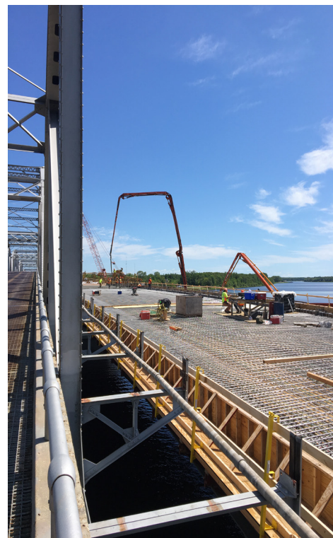
Le béton du tablier du pont est mis en place au moyen de pompes à béton.
