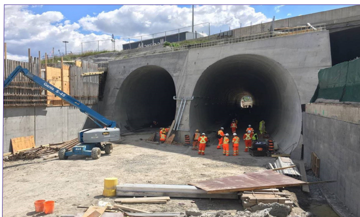
Les tunnels jumeaux et les murs de soutènement sont presque achevés.
