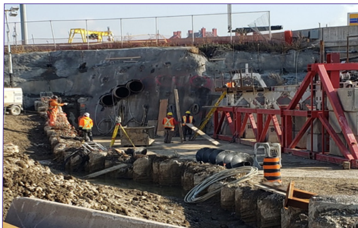
Mise en place initiale des machines d'excavation
