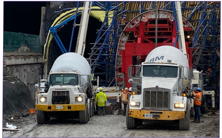
Les nouveaux tunnels jumeaux à côté du tunnel existant.
