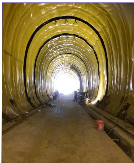
Vue de l'intérieur du tunnel et du système d'étanchéité.
