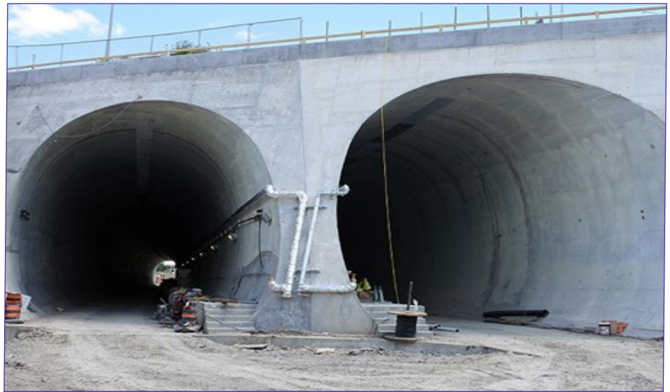
Tunnels jumelés sous les autoroutes 401 et 409.
