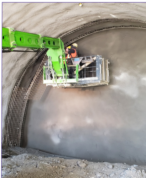
Préparation de la phase de creusage
