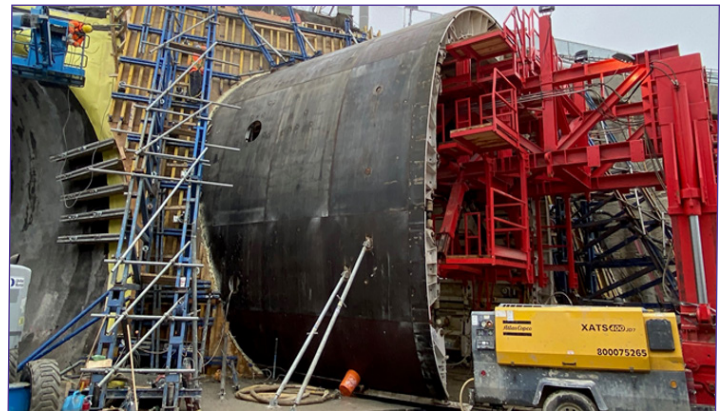
Une réalisation technique de classe mondiale tant à l'intérieur qu'à l'extérieur.
