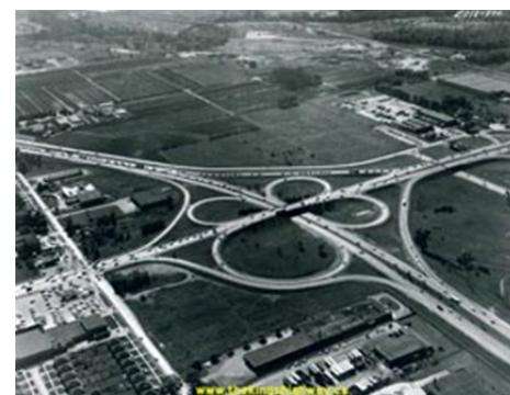
Vue en plongée d'un échangeur en trèfle sur l'autoroute Queen Elizabeth à la hauteur de l'autoroute 27.
