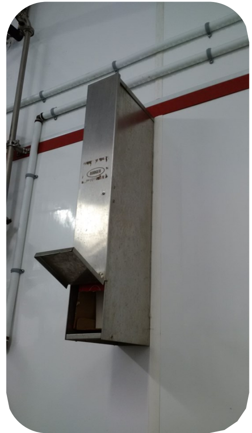
Figure 5: Exemple de contenants pour filtres, étanches à l'eau et à la poussière.
