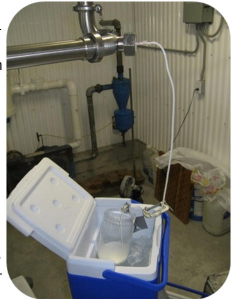
Figure 11— Échantillonnage d'un groupe à l'aide d'un coude d'échantillonnage QMI. Chaque fois que le lait est pompé de la chambre de réception, un flux de lait peut être prélevé dans un récipient à échantillon.
