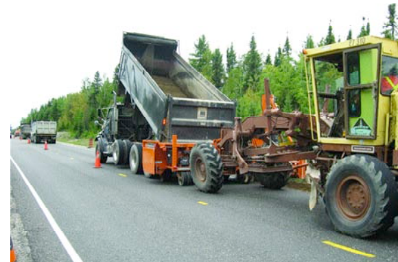
Exécution des accotements
