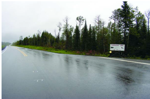
Nouveau revêtement de la route 631
