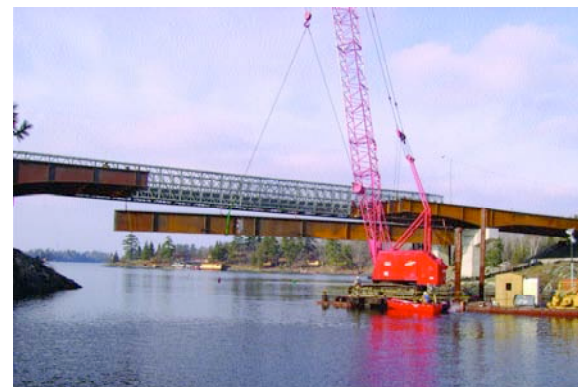
Construction du nouveau pont
