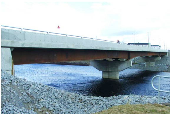
Nouvelle structure à Matachewan
