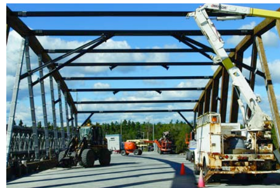
Structure à poutres triangulées
