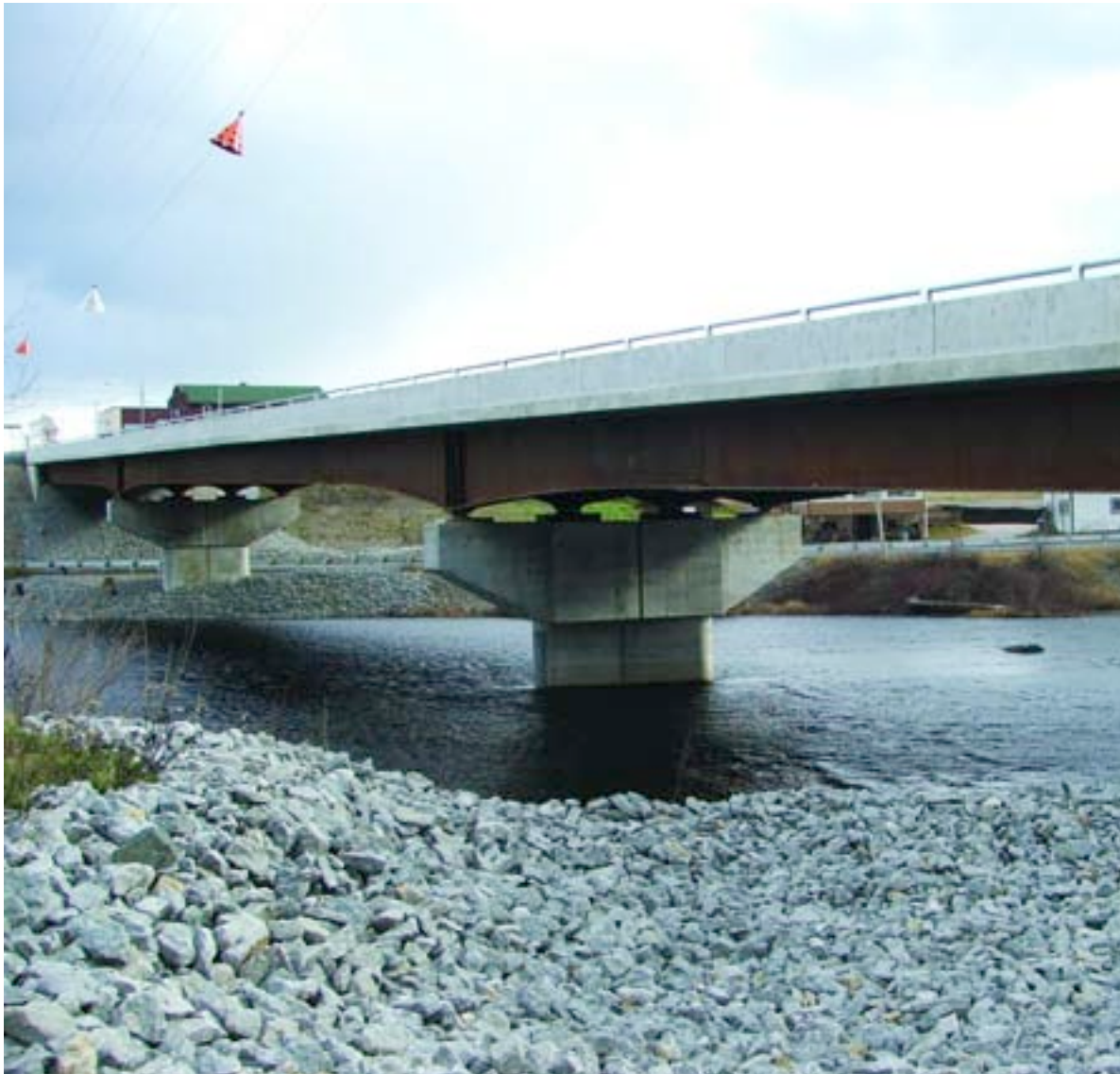
Nouvelle structure à Matachewan
