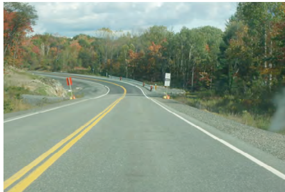
Fin des travaux de reconstruction de la route 518
