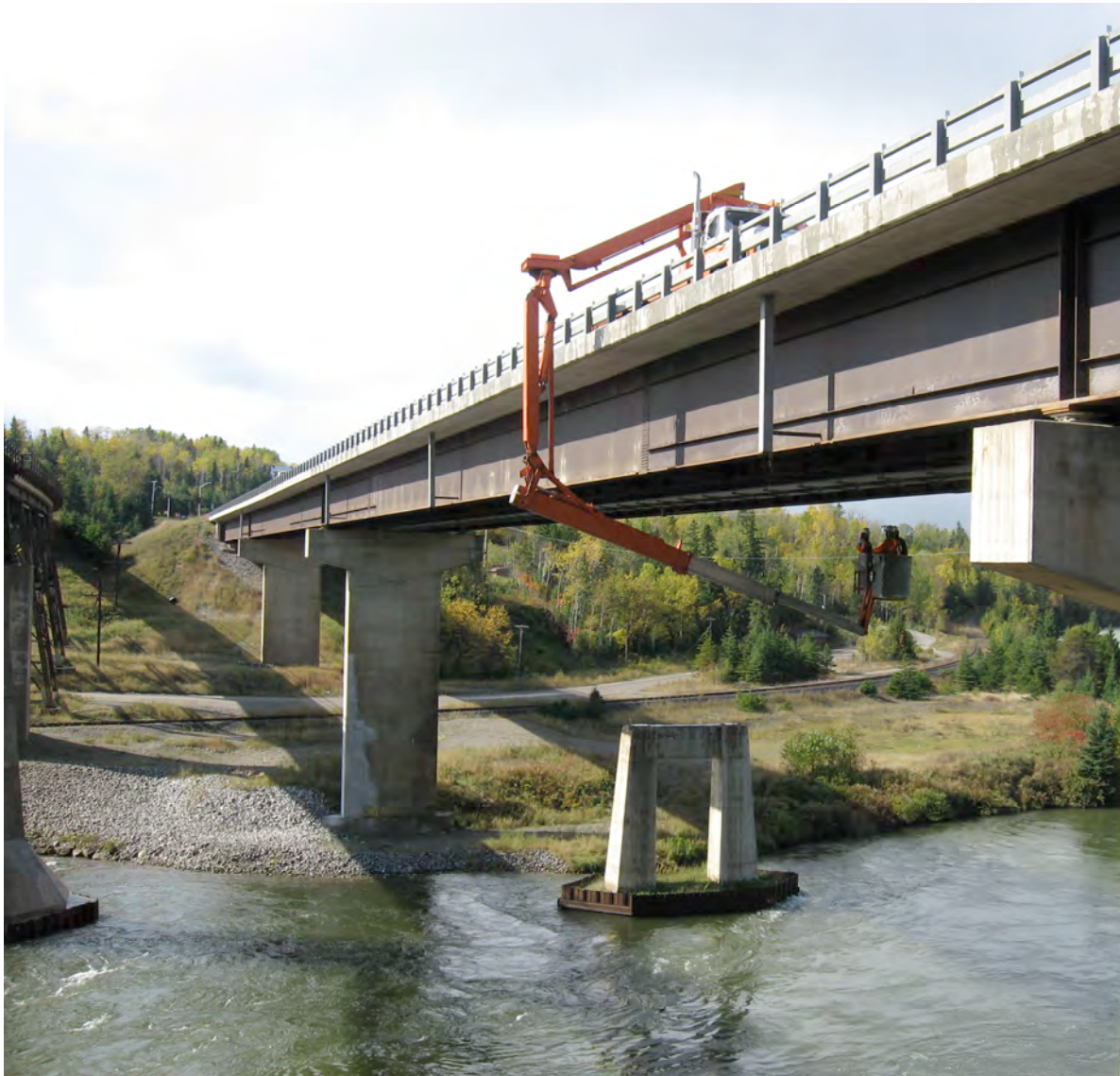
Inspection du pont de la rivière Nipigon
