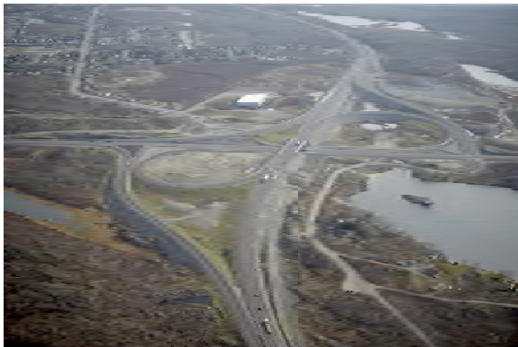
Vue aérienne du nouvel échangeur sur la route 17
