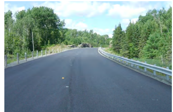
Route 6, après la réfection de son revêtement
