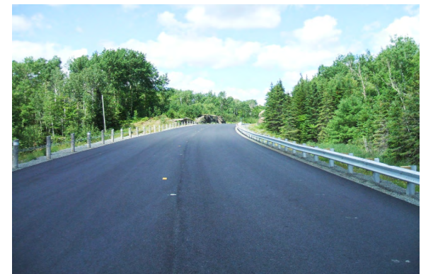
Route 6, après la réfection de son revêtement
