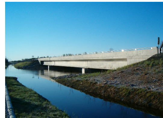
Pont de la rivière Opatatika, route 11
