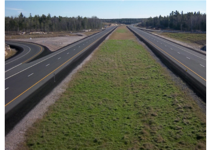
Autoroute 400/route 69 après les travaux
