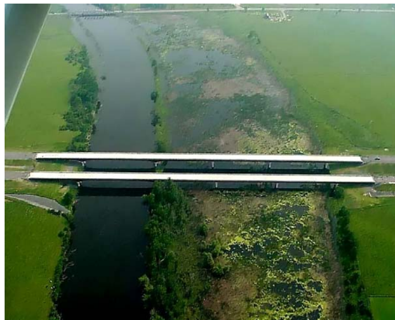
Autoroute 417 – Ponts sur la rivière Mississippi, Ottawa
