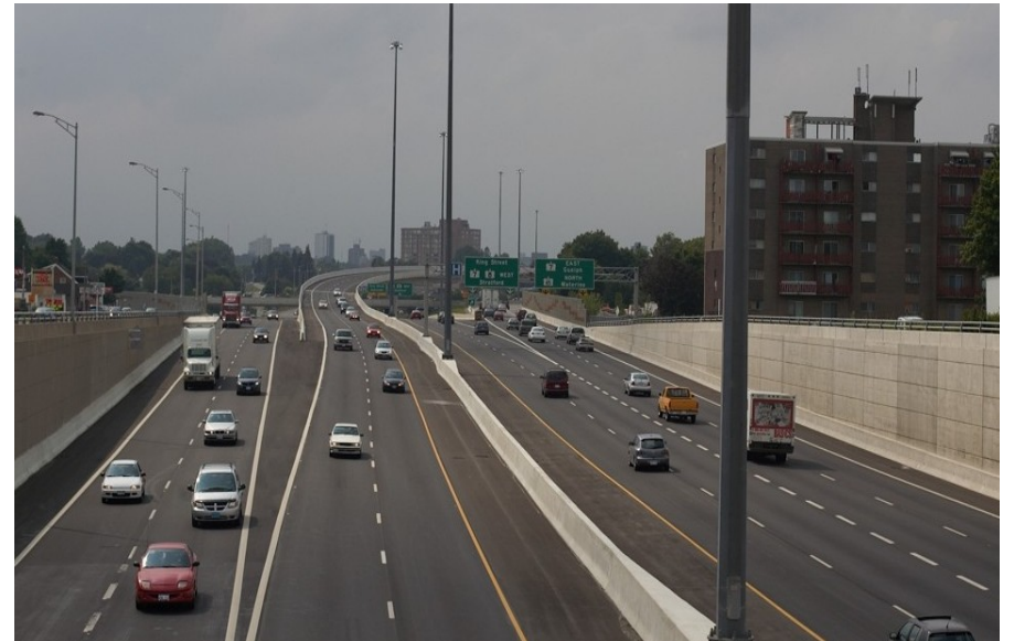
Autoroute 8 – Voie express Kitchener-Waterloo
