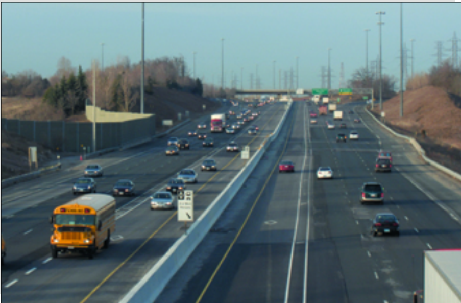
Voies réservées VMO sur l'autoroute 403, à Mississauga
