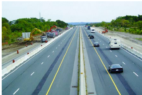
Travaux presque complétés, avant le revêtement final
