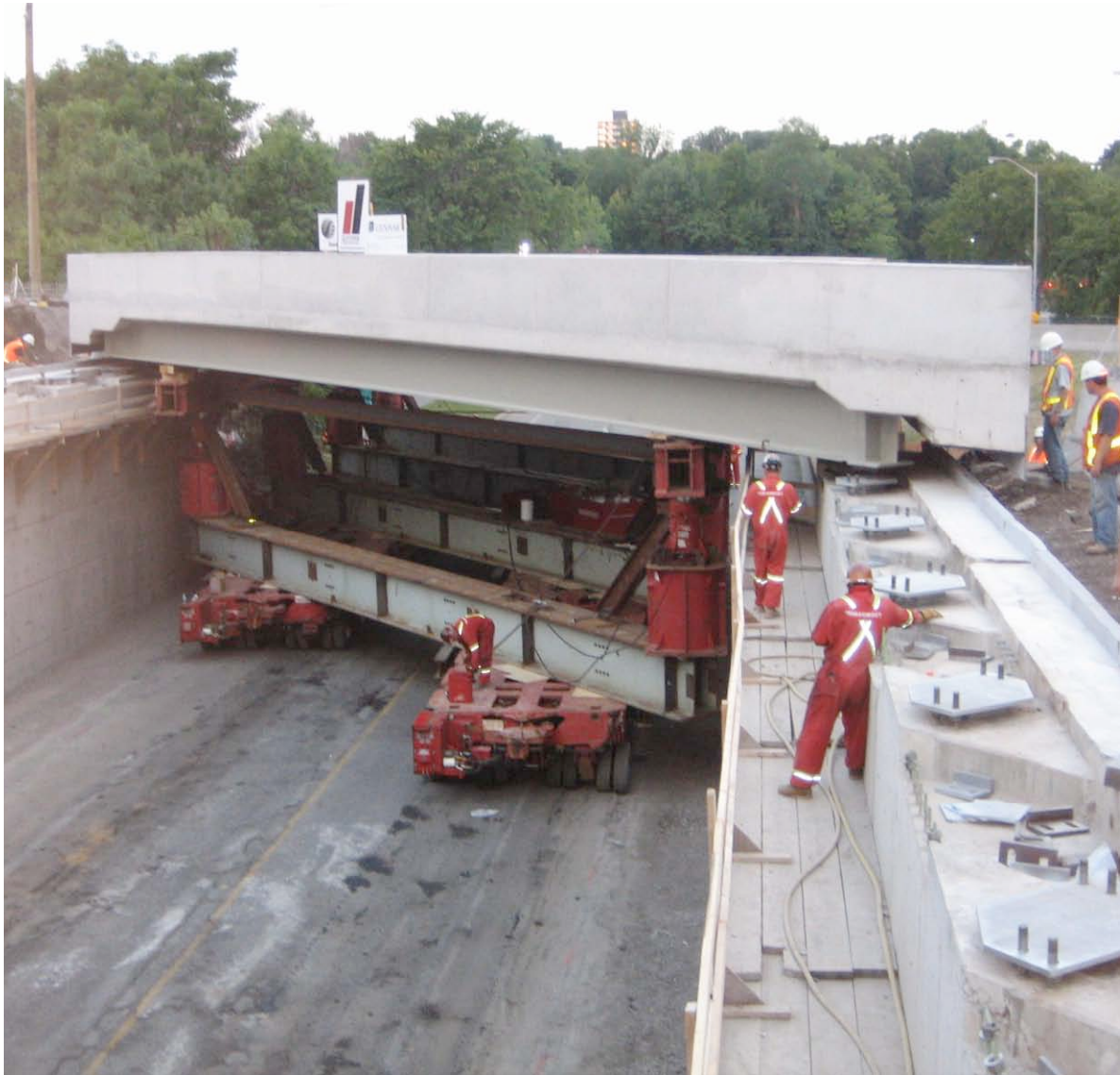
Autoroute 417/Ottawa Queensway, Pont Island Park, installation d'une section du pont.
