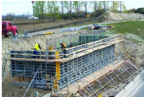
Pont Green Lane – construction d'une culée
