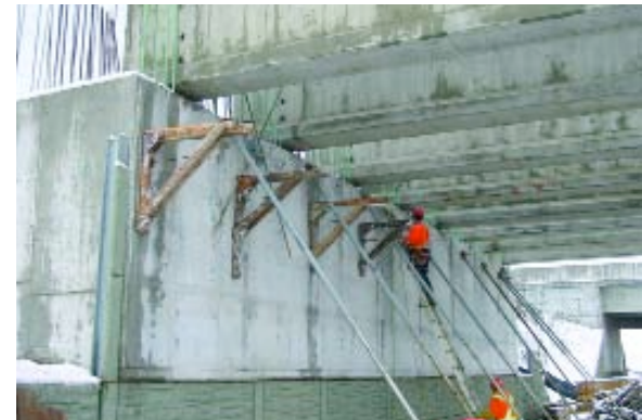
Pont Green Lane Bridge – installation de poutres sur la culée nord
