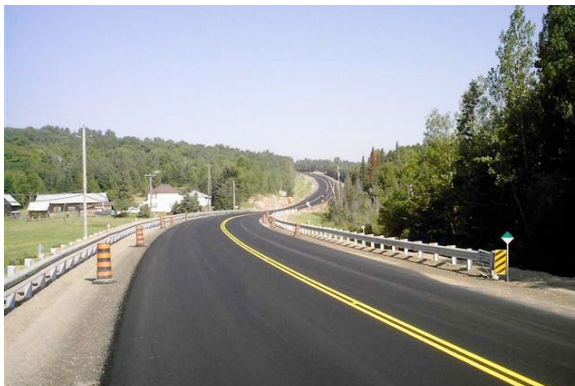
Réfection du revêtement achevée
