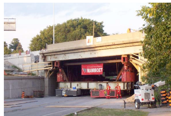
On se prépare à enlever les parties de l'ancien pont.
