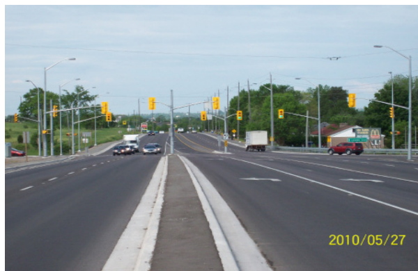
Améliorations apportées à la route 7
