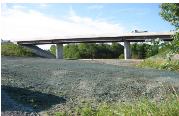
Réfection de la route 12
