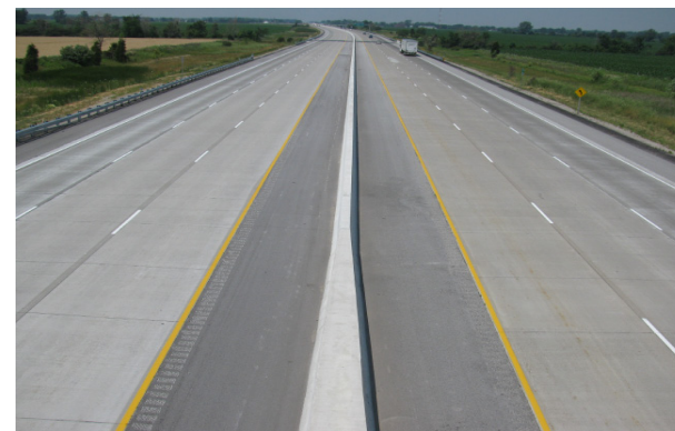
Achèvement de l'élargissement et la réfection de l'autoroute 401
