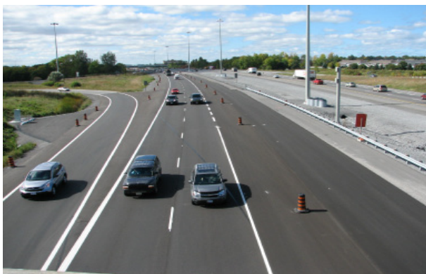
Élargissement de l'autoroute 417 en cours
