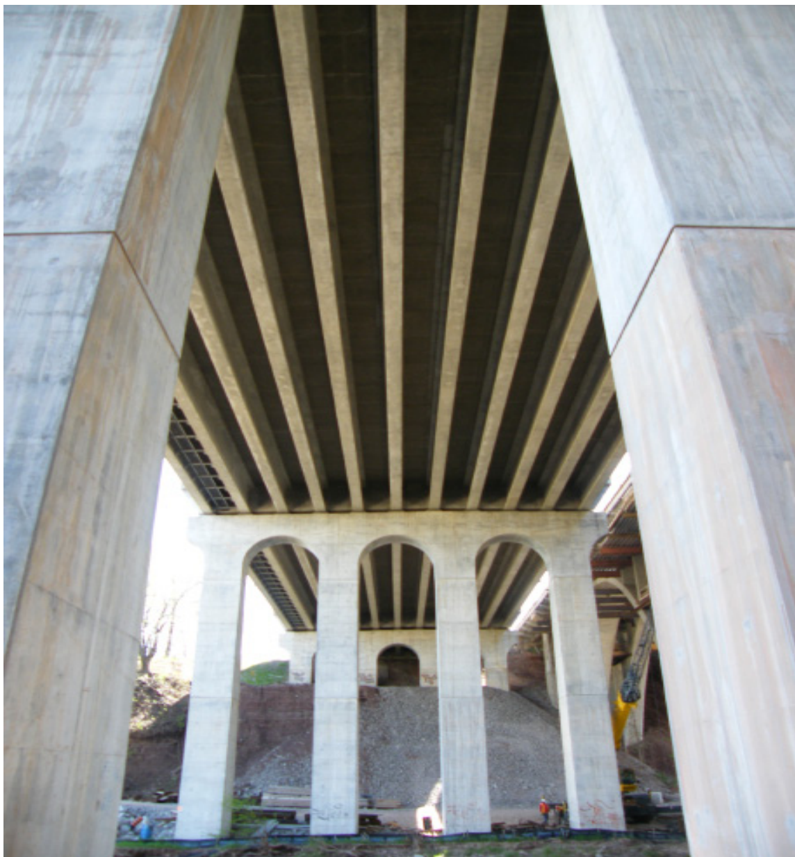
Réfection du pont de l'autoroute QEW
